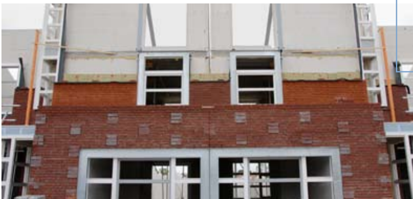
Geïsoleerde spouwmuur met SILKA binnenspouwblad
