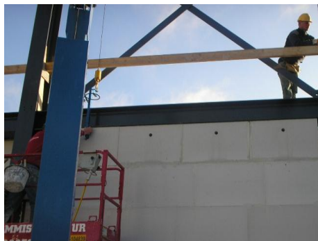
Stap 4: de conussen die uit de elementen zijn geboord kunnen middels lijm weer in de gaten worden aangebracht
