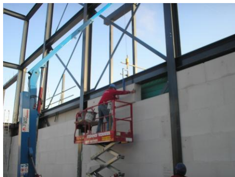
Stap 3: het plaatsen van de elementen onder de constructie
