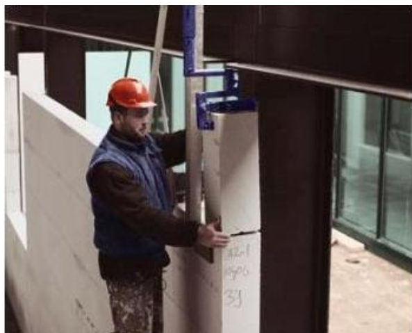
C-beugel met de elementenklem en de passtukkenklem
