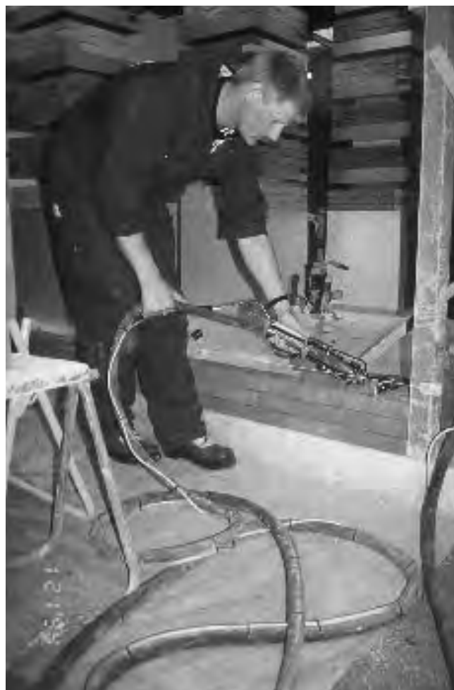
Met behulp van een lijmpistool wordt de lijm mortel aangebracht
