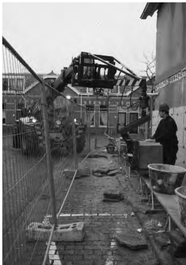
Het opperen van blokken met behulp van een verreiker
