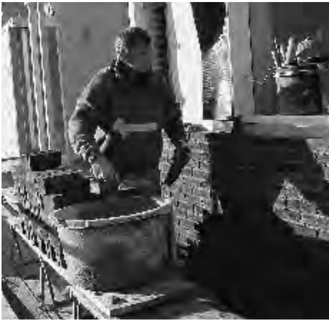
Metselaar aan het werk
