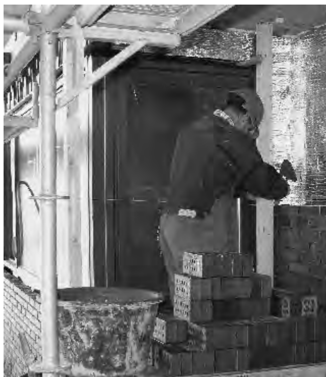
Metselaar aan het werk op een goede werkhoogte
