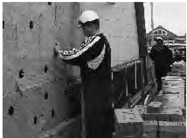
Het aanbrengen van isolatiemateriaal
