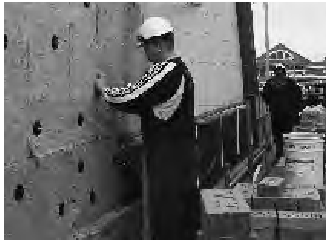
Het aanbrengen van isolatiemateriaal
